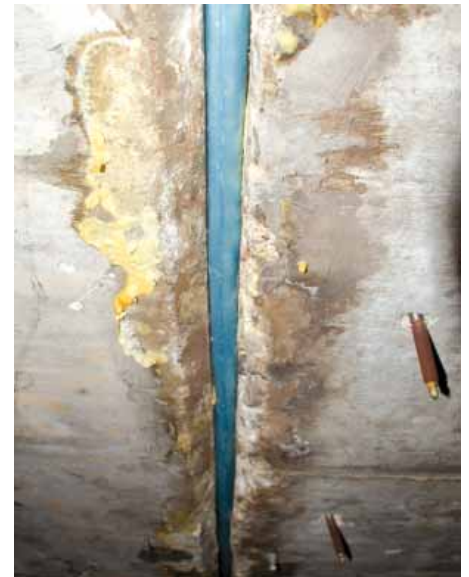
Abgedichtete Bewegungsfuge durchgehend auf einer Länge von 5 m
