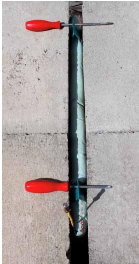
Montage der Abdichtelemente mit Haltebändern zur Fixierung in eine Bodenplatte
